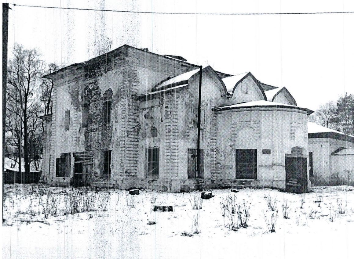
Фото здания, расположенного по адресу: ул. Акулова, д.37 в г. Каргополе
