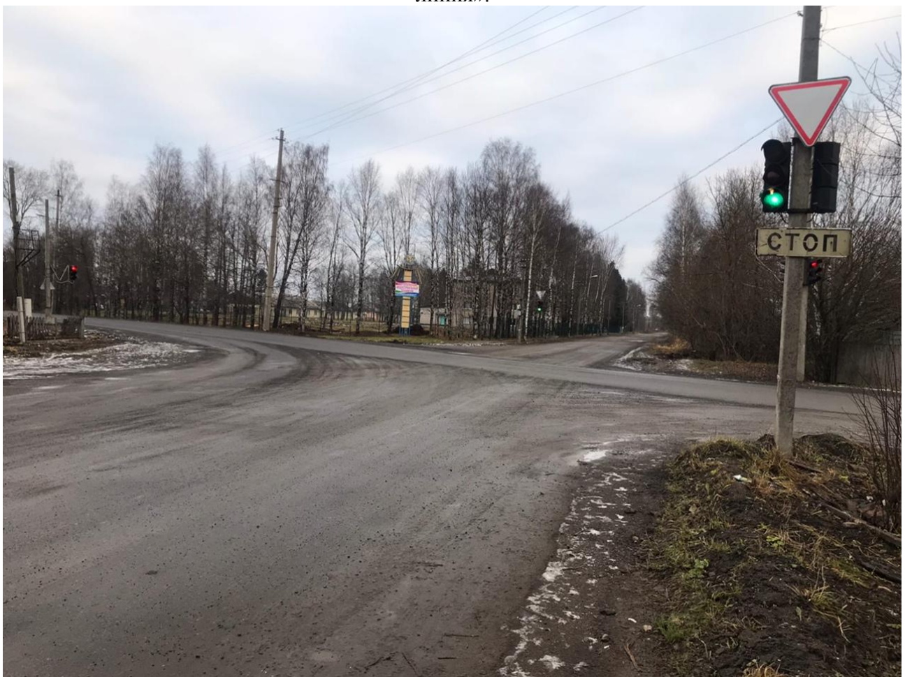
Рис. 1.7.1.6 – пересечение ул. Державина - ул. Архангельская отсутствует разметка 1.12 – «стоп-линия».
