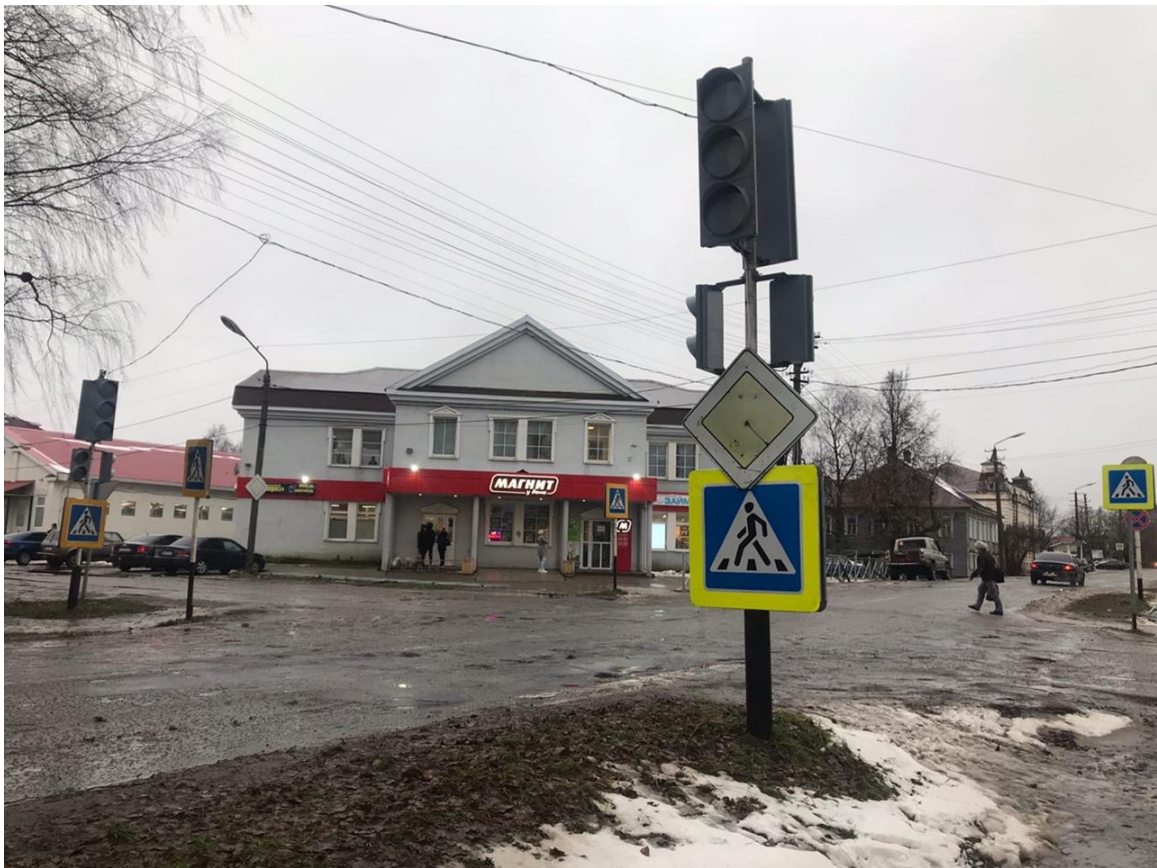
Рис. 1.7.1.5 – пересечение ул. Ленина - ул. Ленинградская – отсутствует разметка 1.12 – «стоп-линия».
